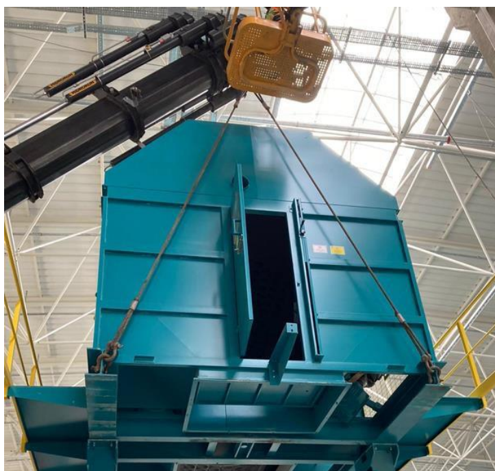
Sl. 1 i 2: podizanja sita kod montaže
